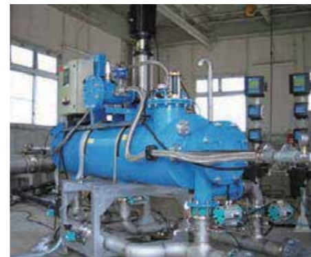
MT44P×1台設置 (国内浄水場・日量700m 3 処理)
