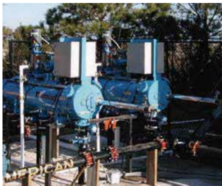
MT44P×2台並列設置 (米国下水最終処理・日量1,400m 3 処理)
